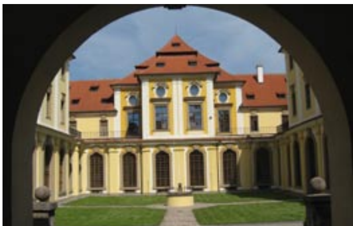
Zámek Zbraslav - sídlo Sbírký orientálního umění Národní galerie v Praze mezi lety 1972 a 2009. Do roku 1994 také sídlo Sbírký českého sochařství a Archivu NG. Rozsáhlá stálá expozice Umění Asie ve 22 sálech zámku Zbraslav byla v provozu jedenáct let (1998-2009).
